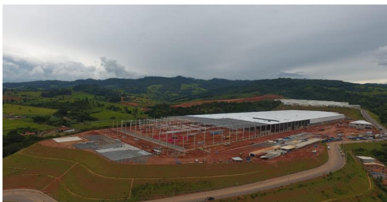
(Foto da Obra em Jan/2021)
