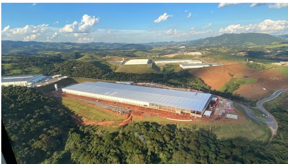
(Foto da Obra em Fev/2021)
