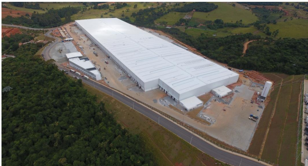
(Foto da obra em março/2021)
