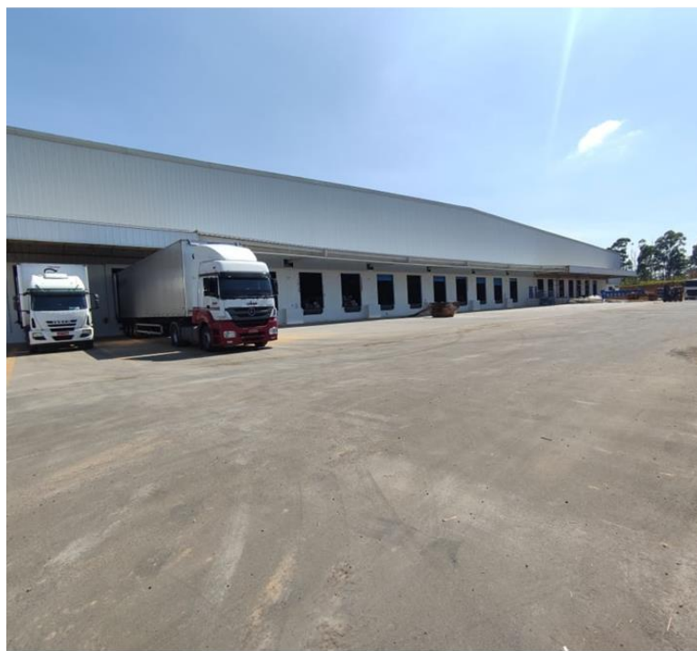
(Fotos da obra em novembro/2021)
