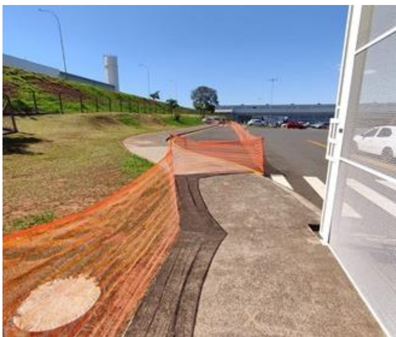
(Fotos obra da portaria em janeiro/2022)
