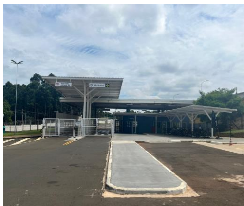
Retrofit do Galpão Hortolândia II
