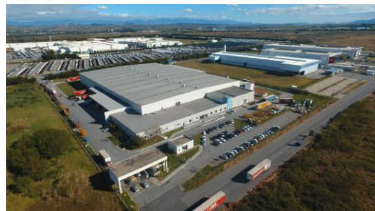
Galpão Resende I
