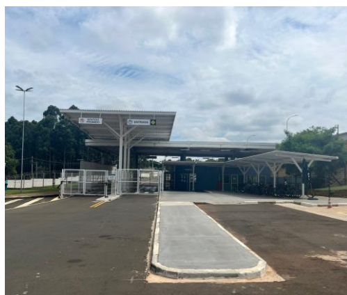
Retrofit do Galpão Hortolândia II
