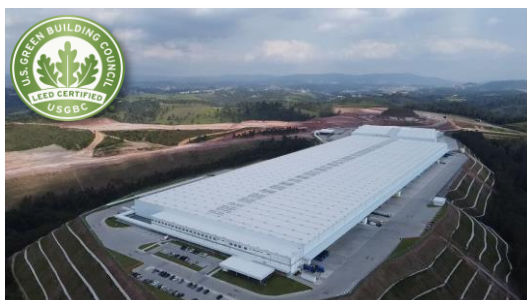
Galpão WT RBR Log
