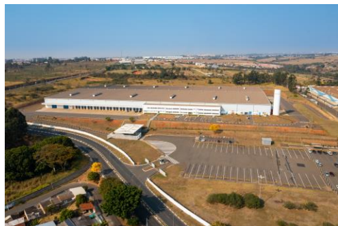
Galpão Hortolândia II
