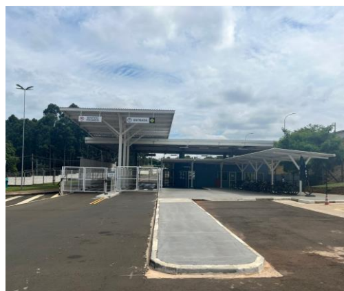
Retrofit do Galpão Hortolândia II
