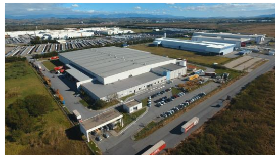
Galpão Resende I
