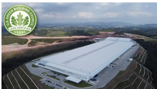
Galpão WT RBR Log
