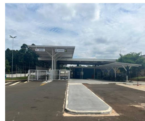
Retrofit do Galpão Hortolândia II
