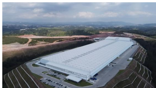
Galpão WT RBR Log
