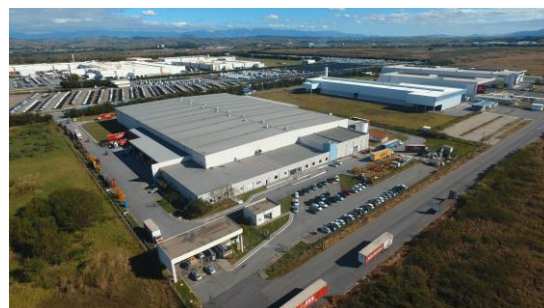
Galpão Resende I
