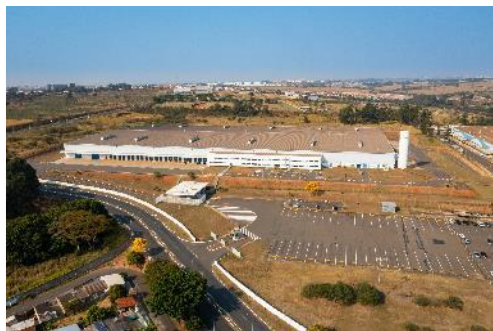
Galpão Hortolândia II
