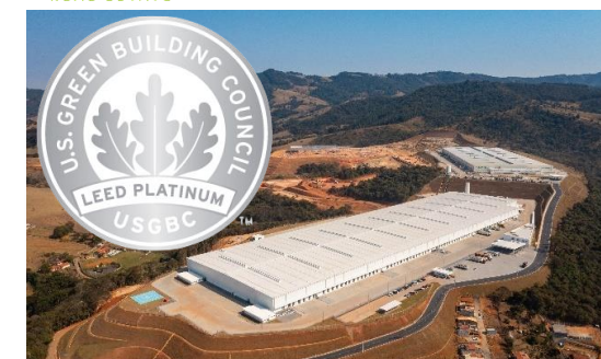
Galpão Extrema I, Extrema/SP
