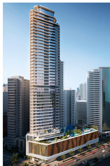
Alaia (em Construção) - Embraed
