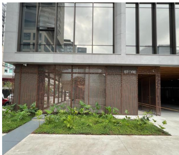
Exterior da Fachada Ativa
