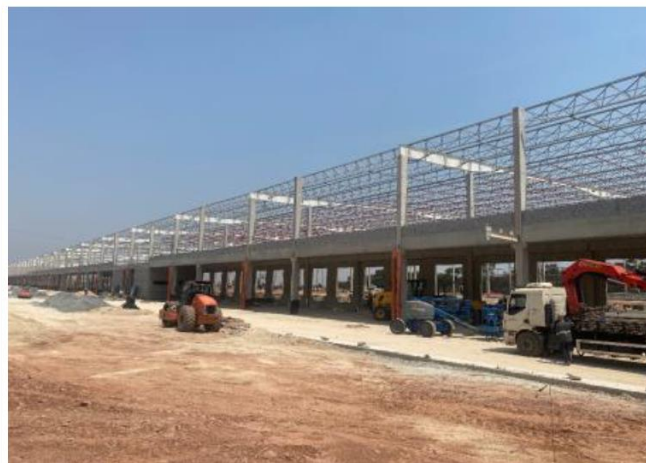
G 100 – ESTRUTURA METÁLICA
