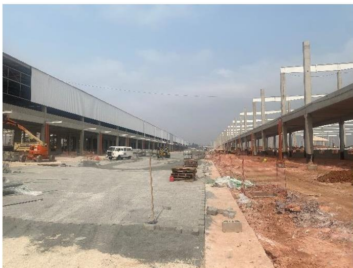
ÁREA EXTERNA – PISO INTERTRAVADO
