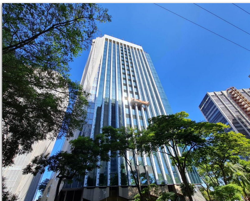
Imagem 1: Fachada do Ed. Mário Garnero
