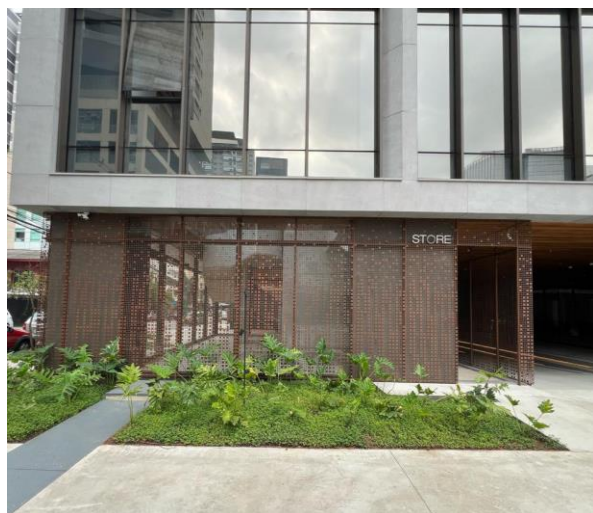
Exterior da Fachada Ativa
